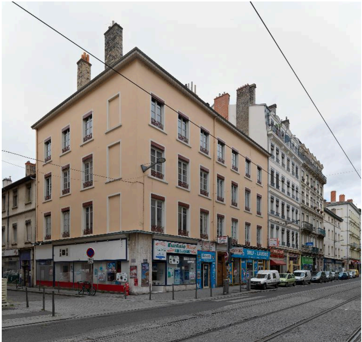
Vue de situation au sein de l'ilot
