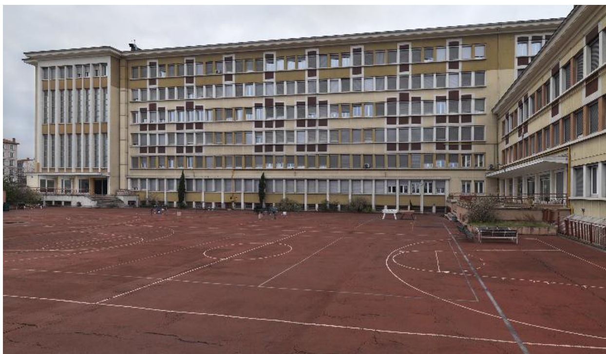
Bâtiment principal, élévation postérieure, depuis l'est
