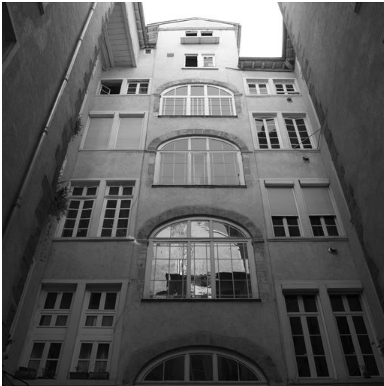
Premier bâtiment, élévation sur cour, vue générale des étages
