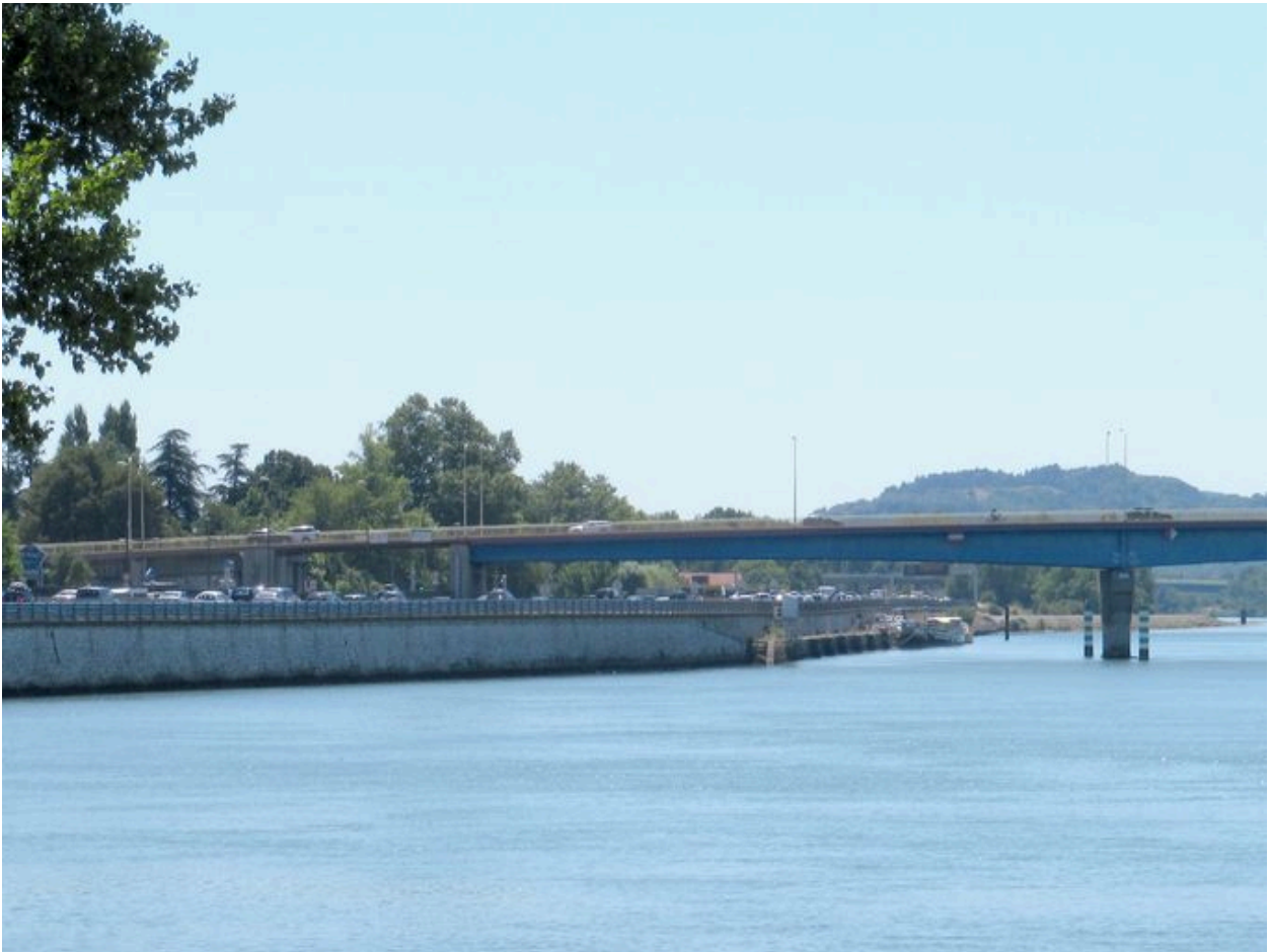
Vue partielle, travée de rive et travée gauche, face amont (depuis la rive gauche)
