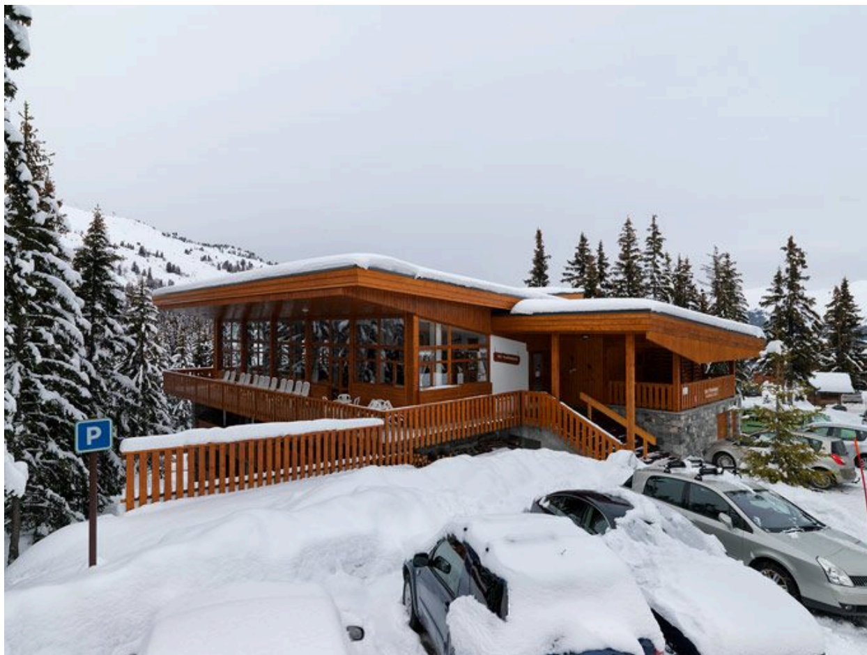
Le Florineige 1. Vue d'ensemble depuis le sud-est
