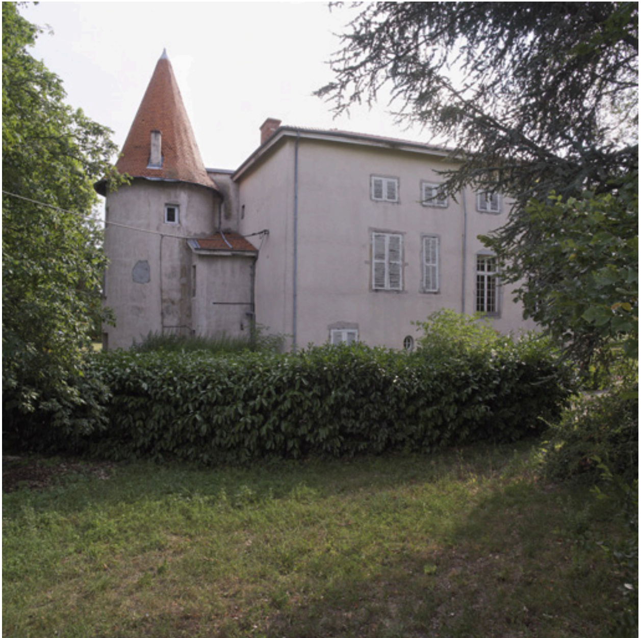
Vue de l'aile nord, élévation nord (partie est).
