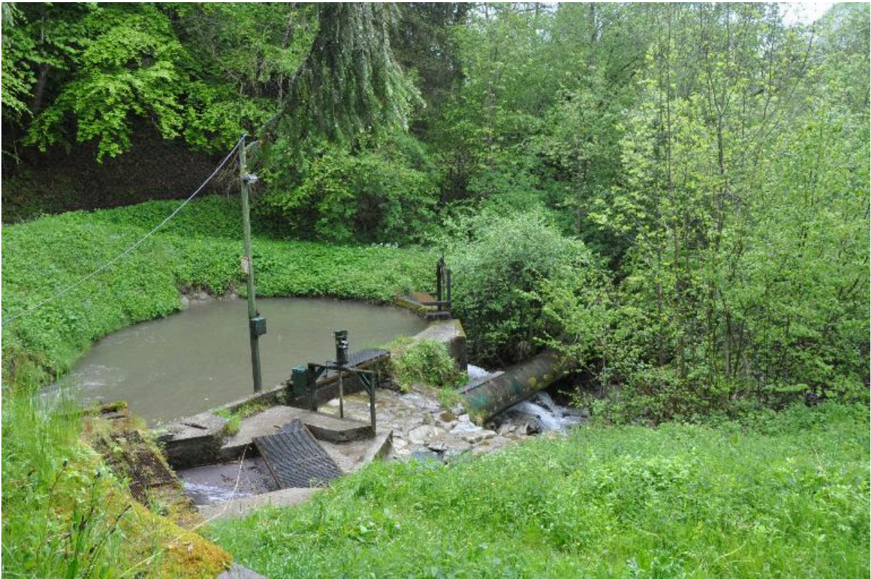
Vue de la prise d'eau sur le nant de la Serraz.
