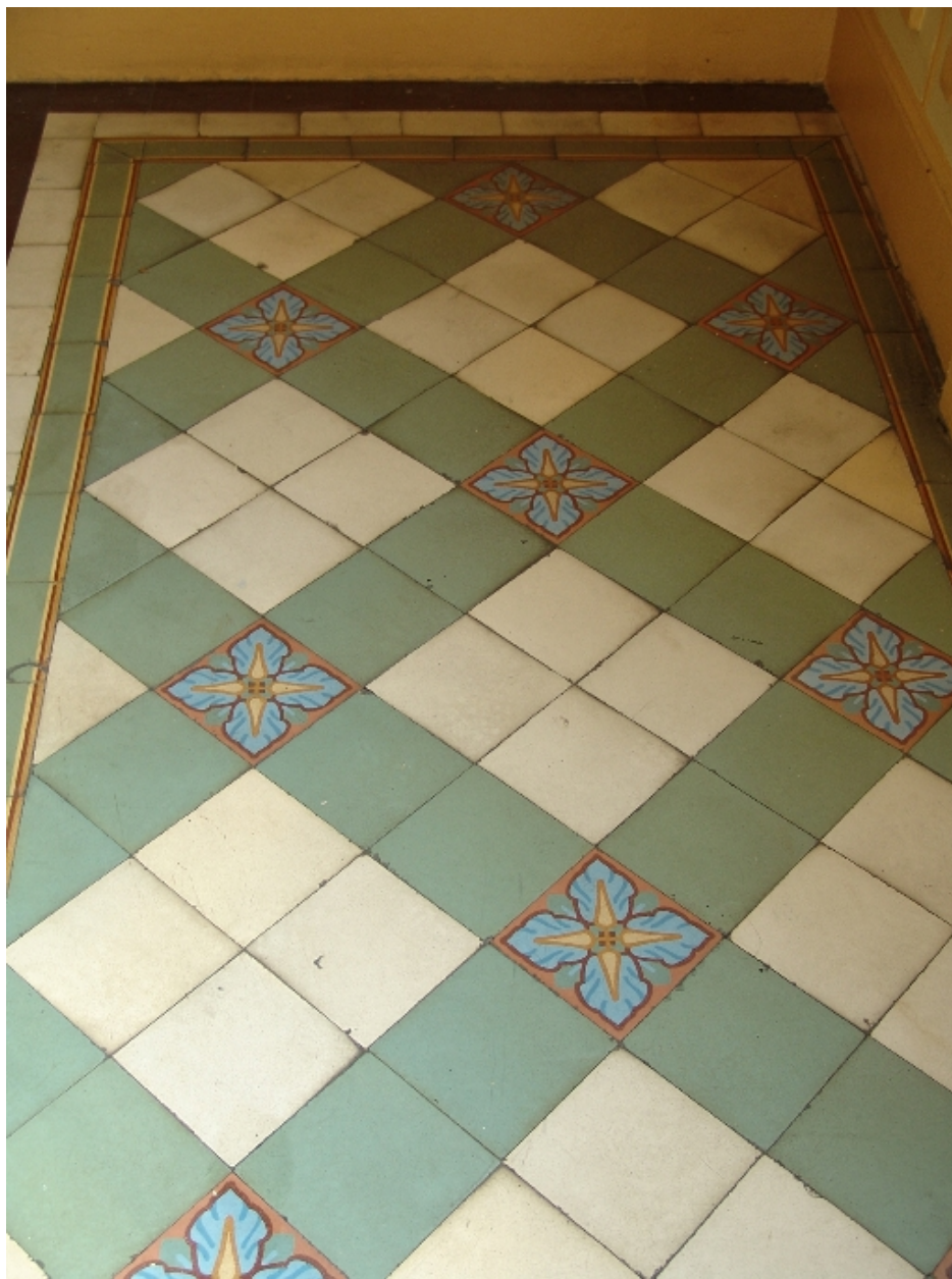
Sol en carreaux de ciment
