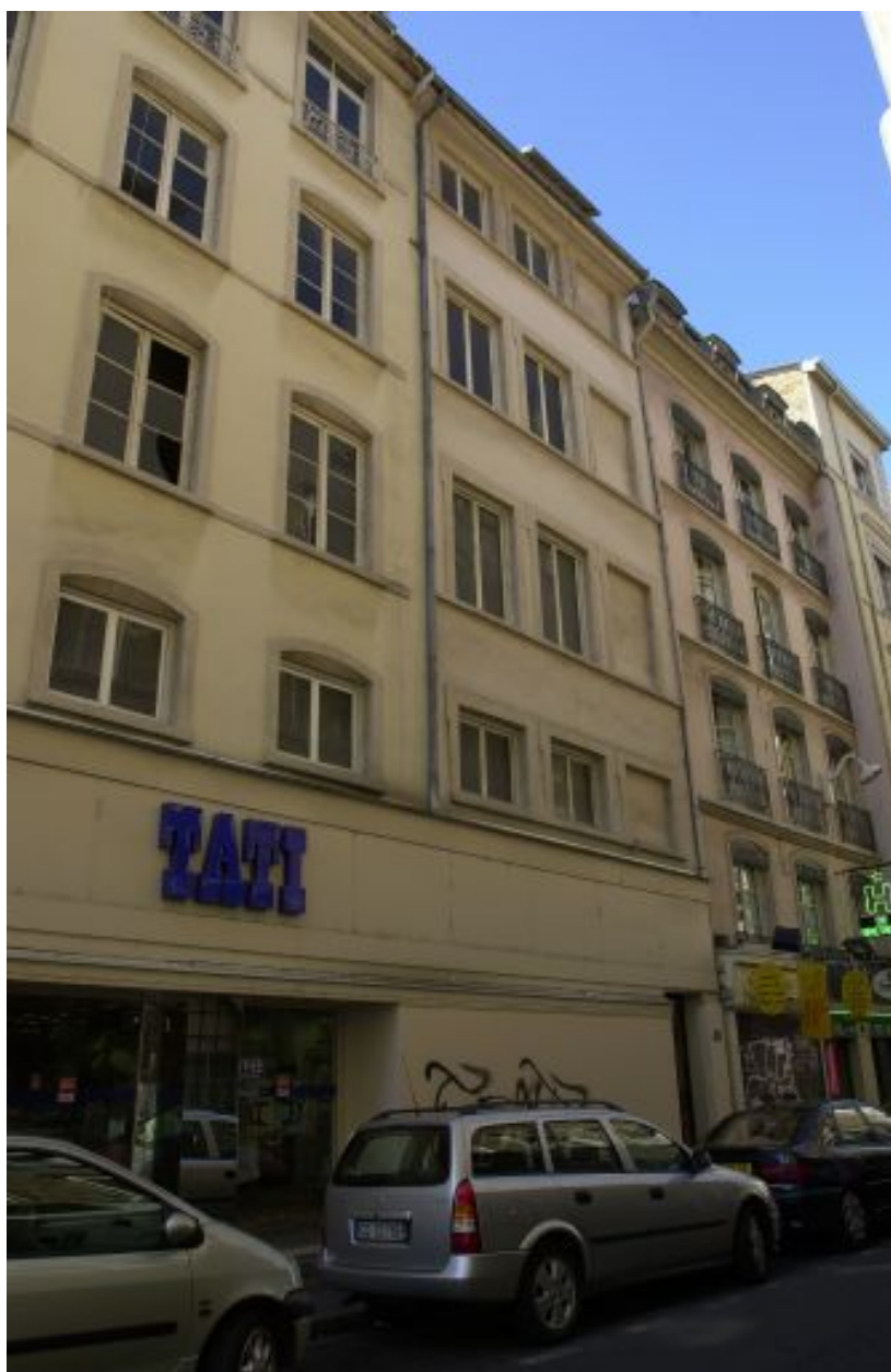
Façade sur rue, vue générale
