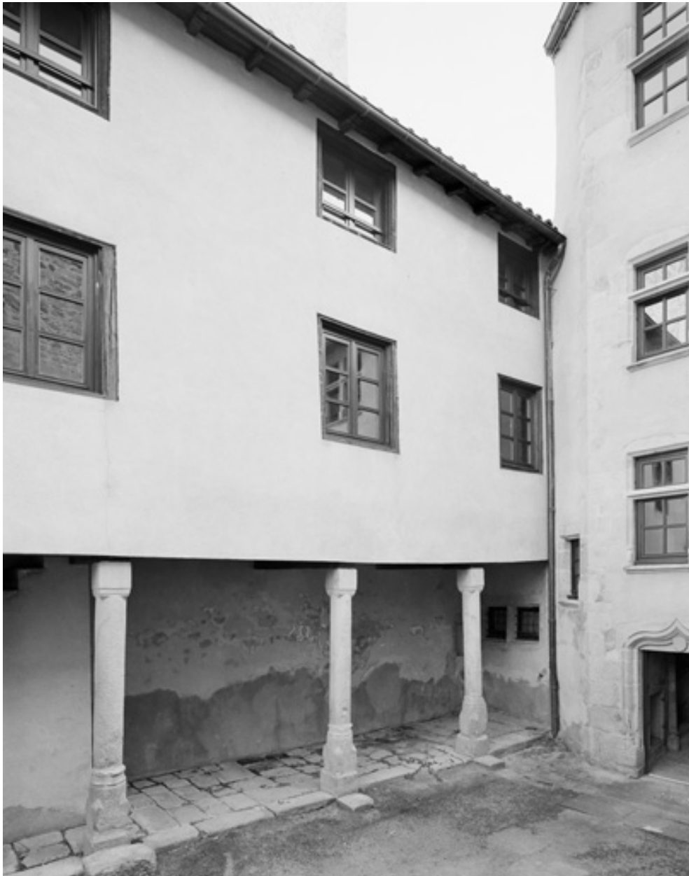
Galerie sur cour reliant les deux corps de bâtiments.
