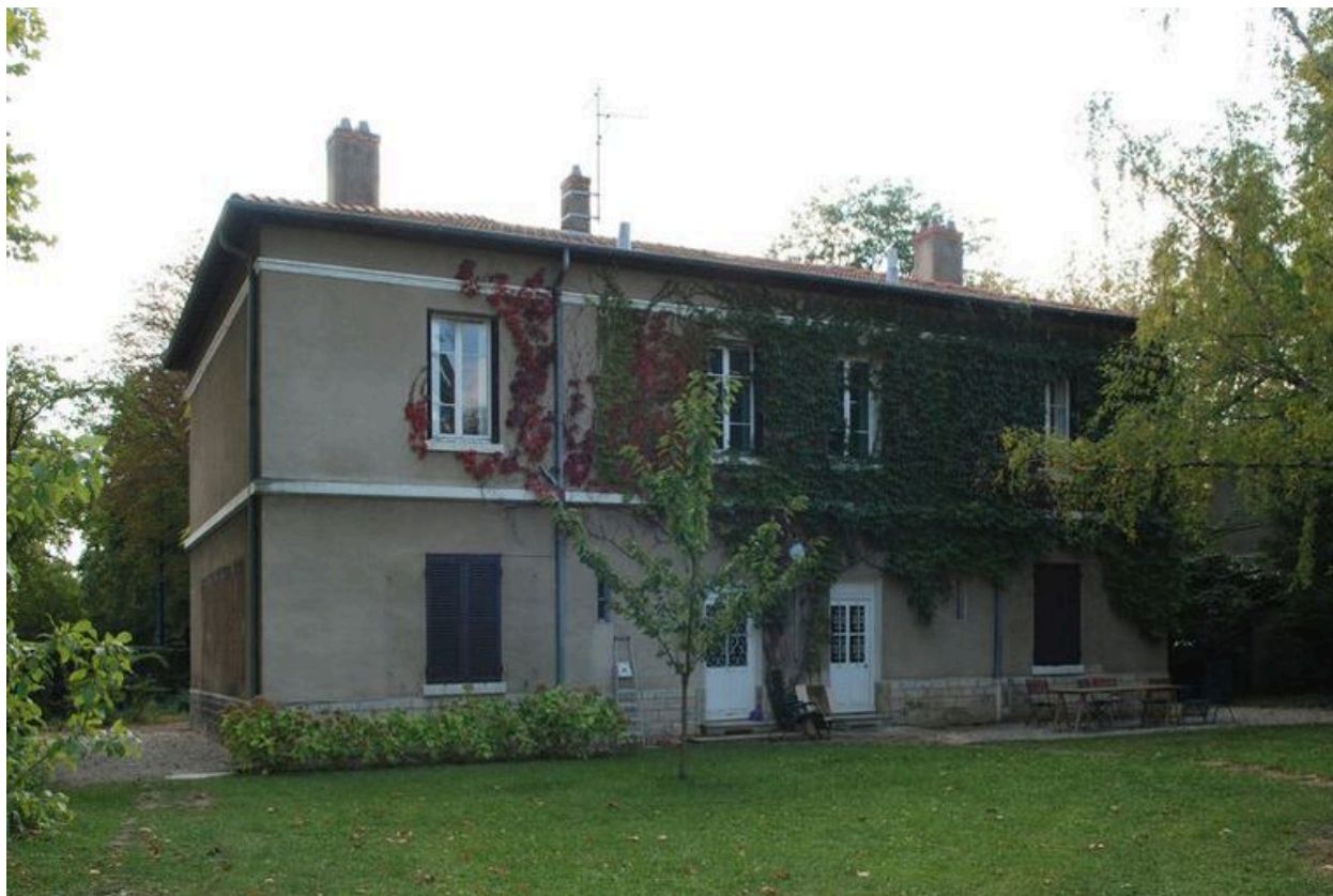
Bâtiment 515, façade postérieure (nord). On retrouve deux portes jumelles donnant sur le jardin
