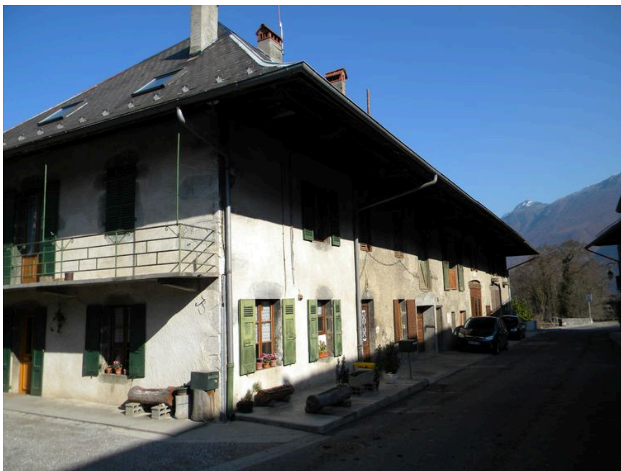
Vue de trois quart avec la façade principale.
