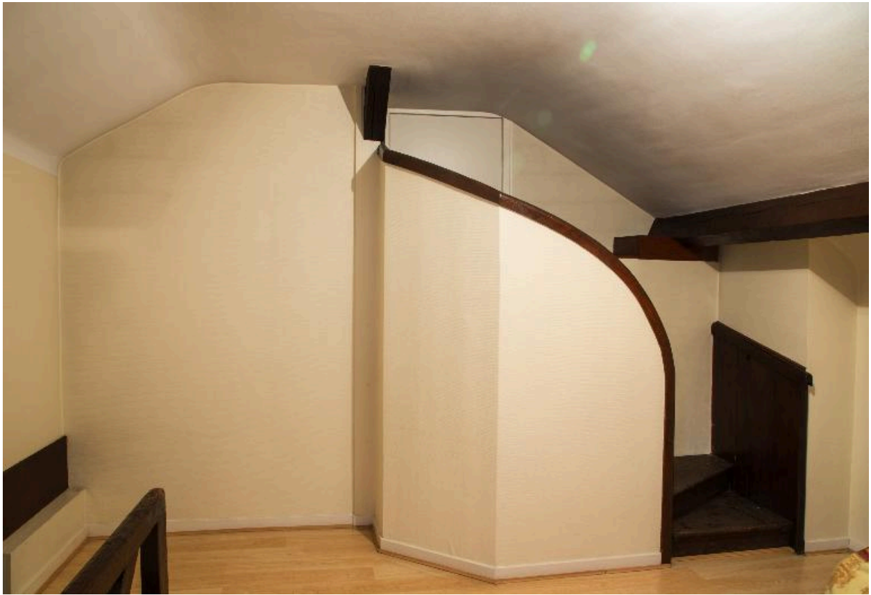
Escalier intérieur menant aux combles.
