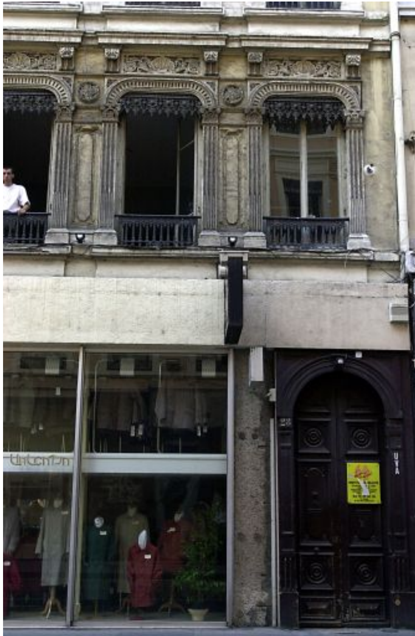
Façade principale, détail de la porte et des fenêtres du 2e niveau
