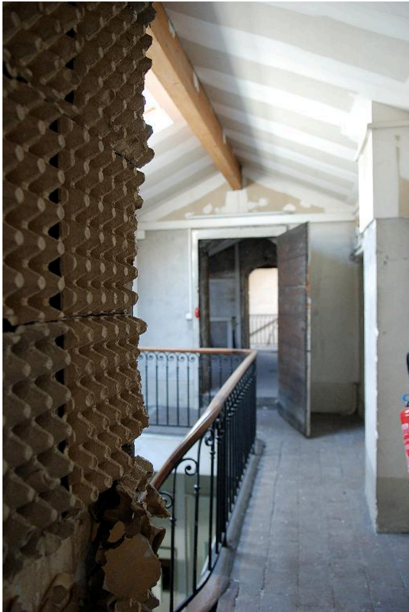
Etat en 2010 : bâtiment réservé à l'administration, l'escalier
