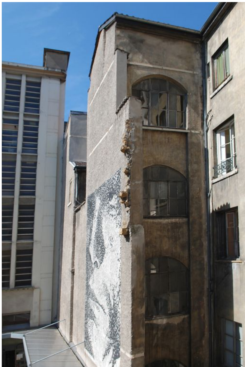
Elévation latérale nord, mur de la cage d'escalier
