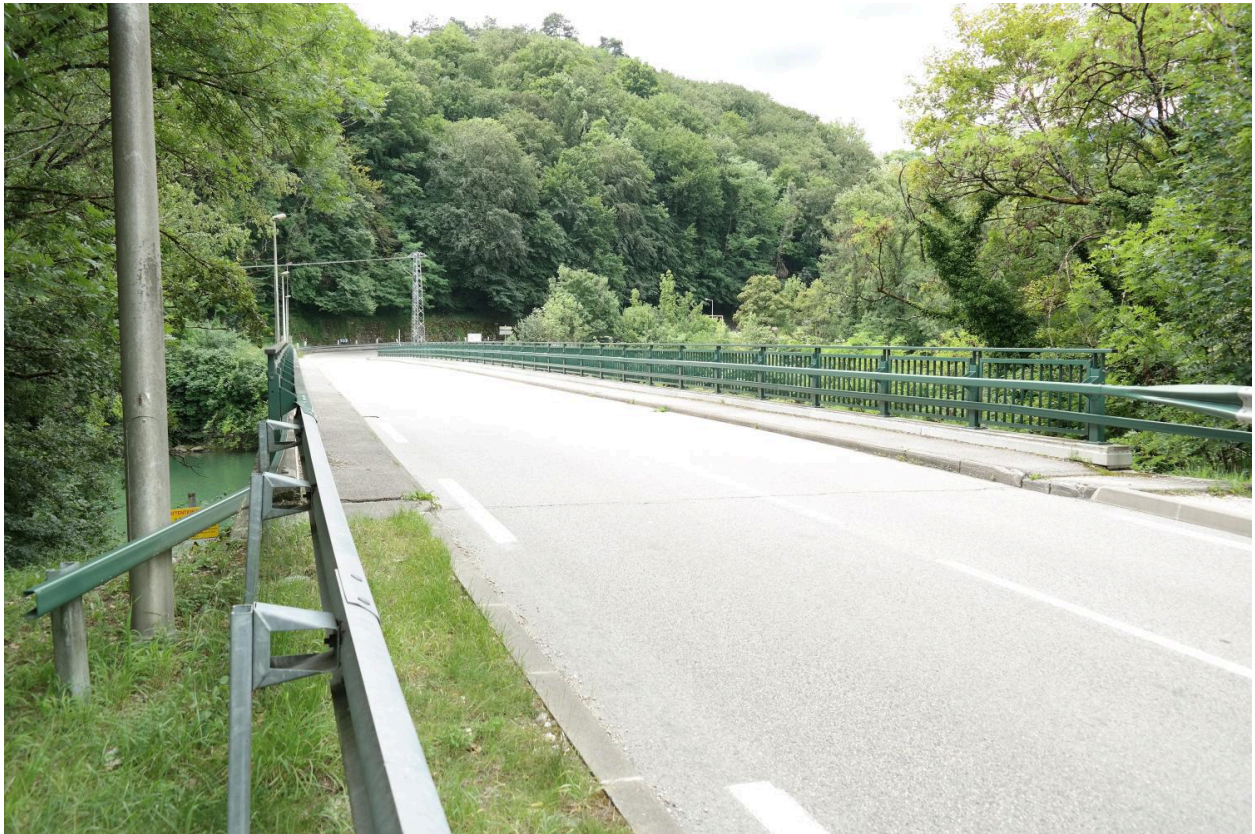
Pont du Fier. Chaussée depuis la rive Haut-savoiarde
