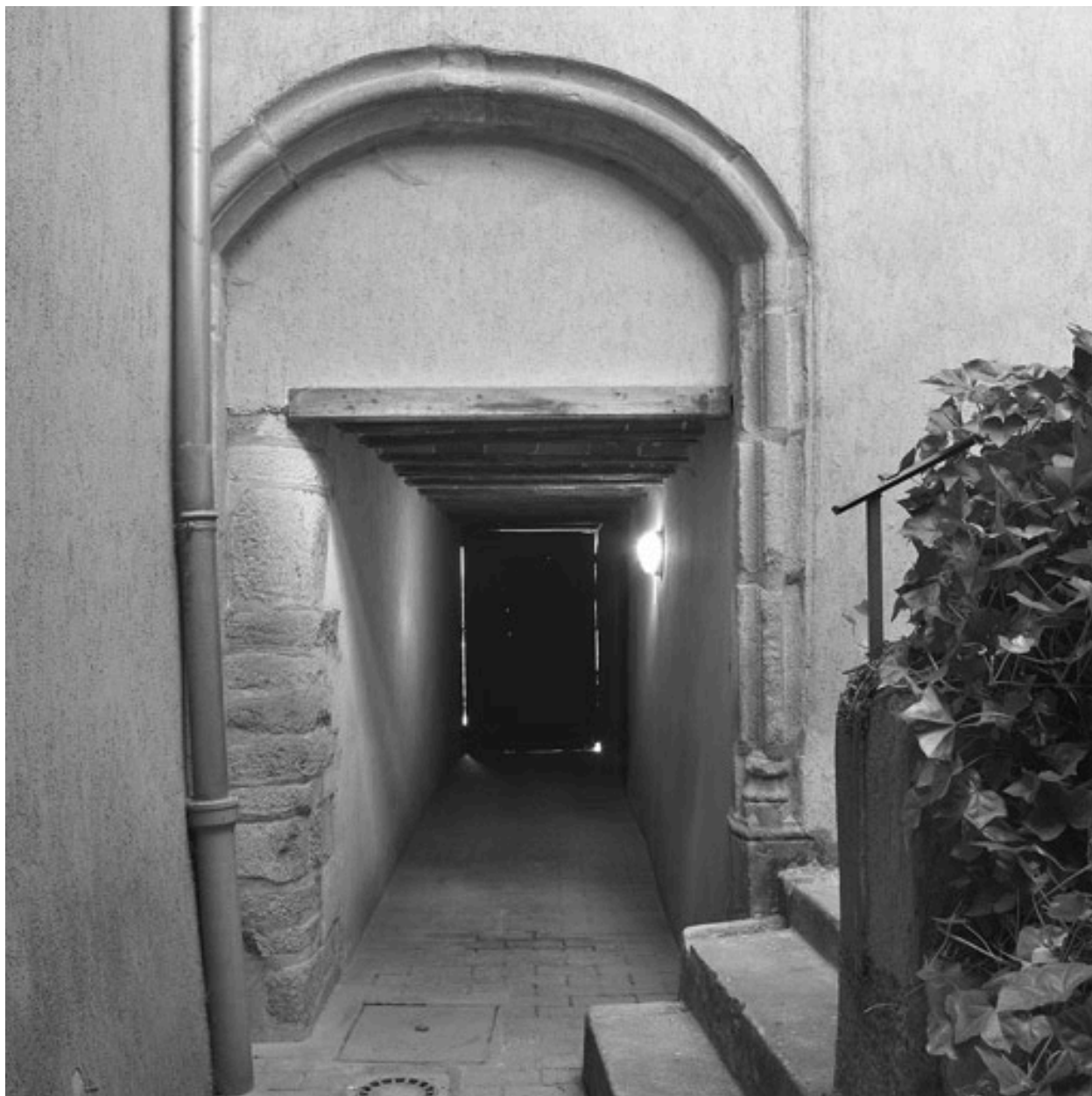
Cour intérieure, mur ouest : allée ouvrant sur la rue des Clercs (corps B).
