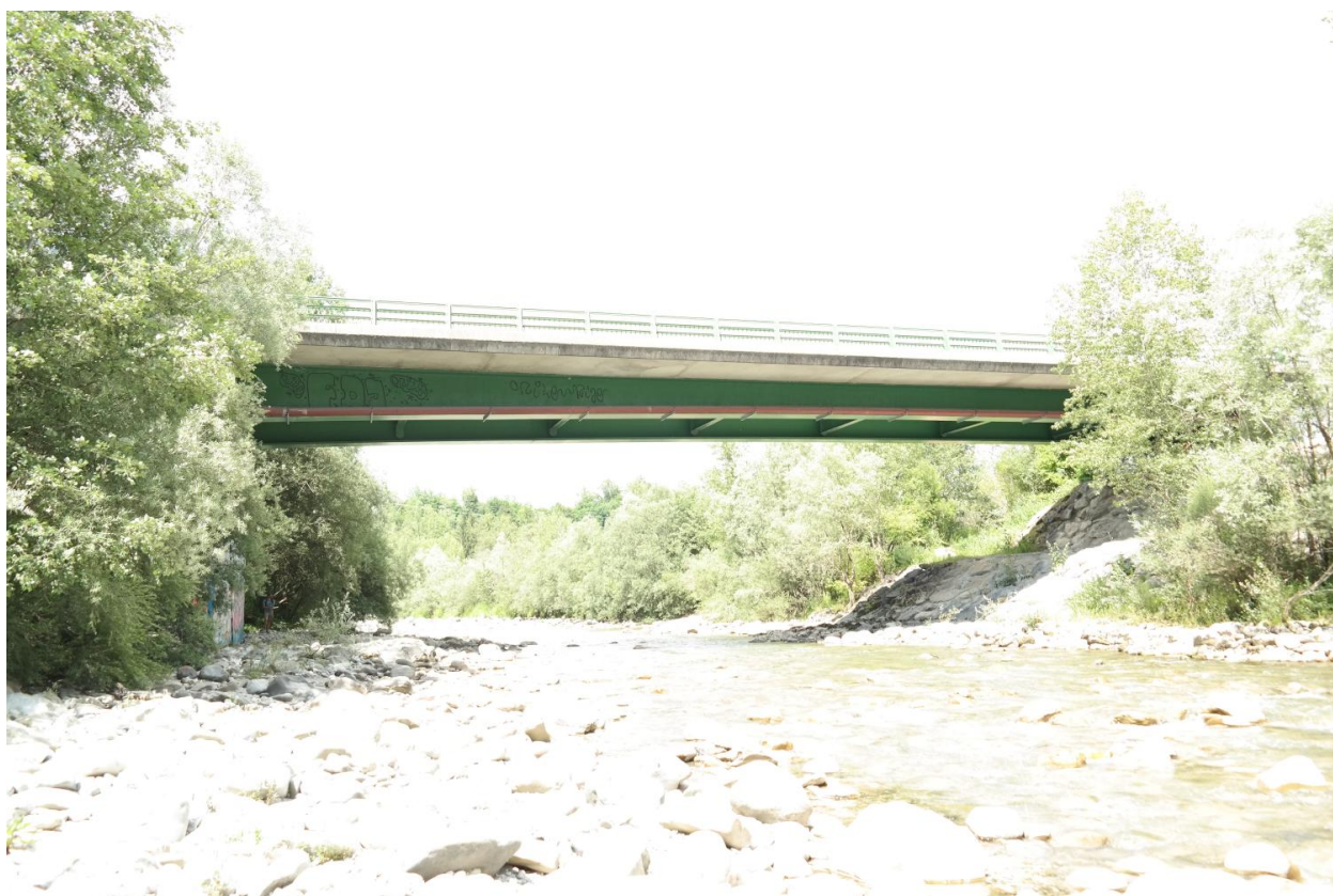
Pont sur le Fier, vue de la face aval
