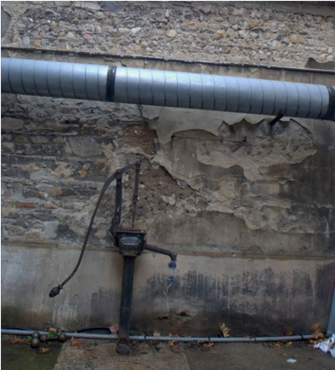
Vue de la pompe à eau et du mur mitoyen construit en moellons, galets et pisé
