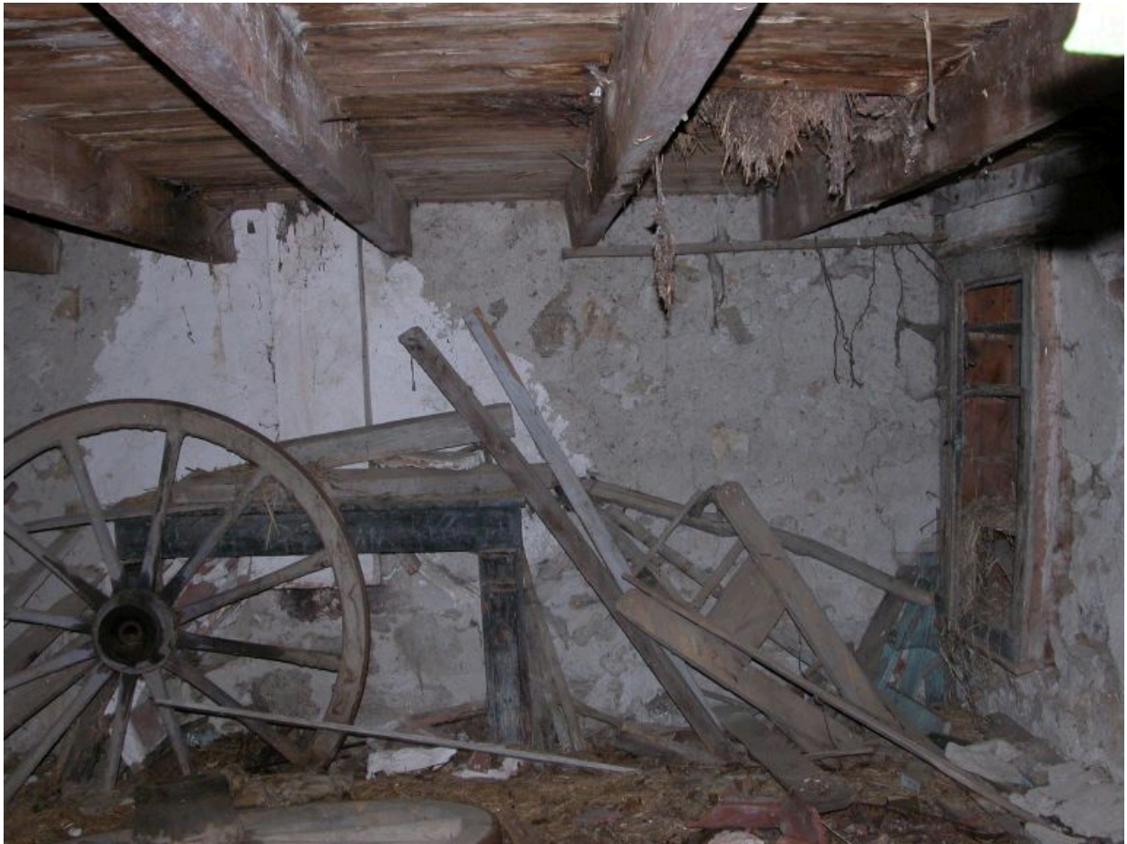
Vue intérieure du rez-de-chaussée.
