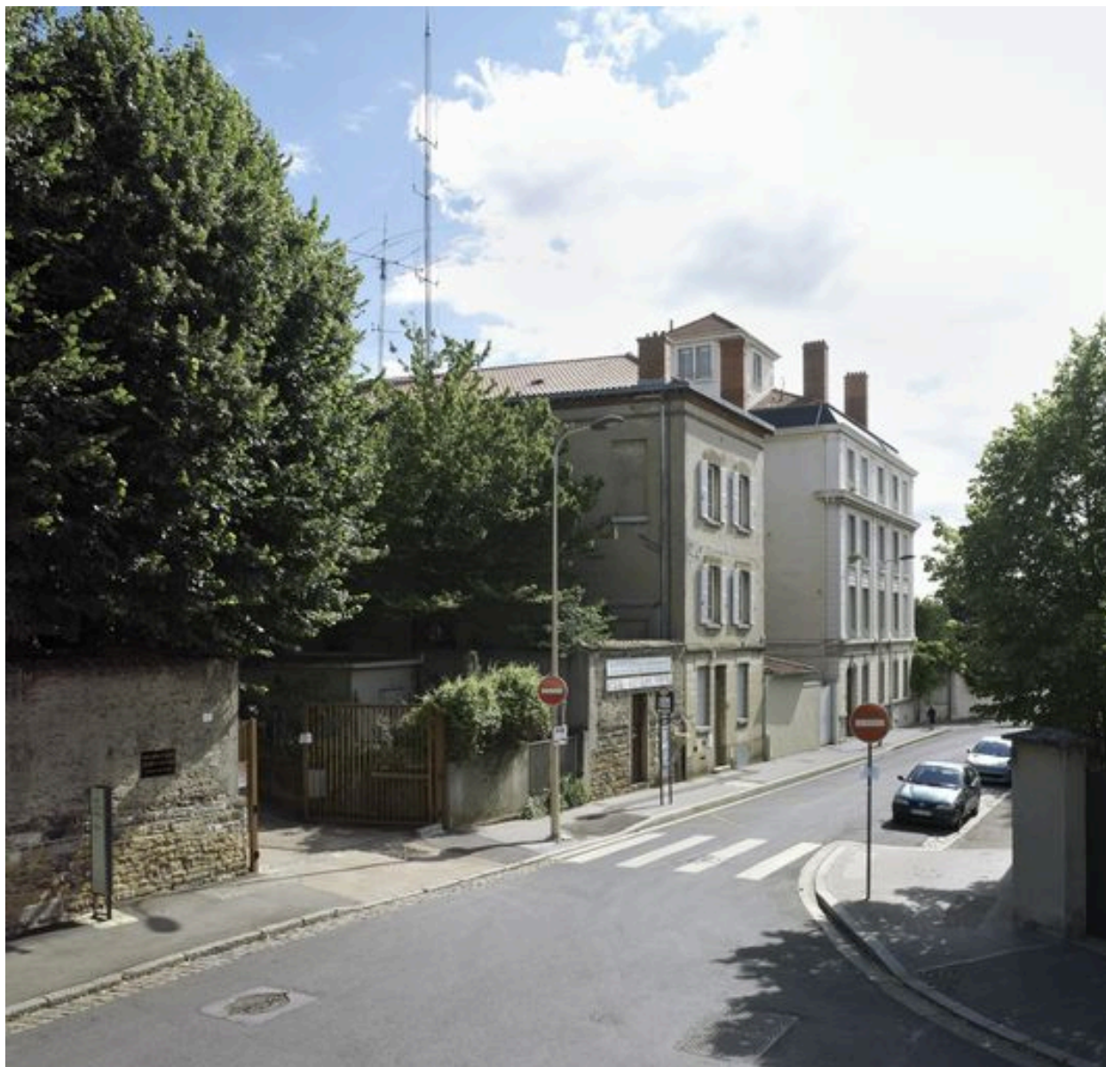
Vue d'ensemble de l'entrée, 23 rue Roger-Radisson, et des immeubles n° 23 bis et 25 rue Roger-Radisson
