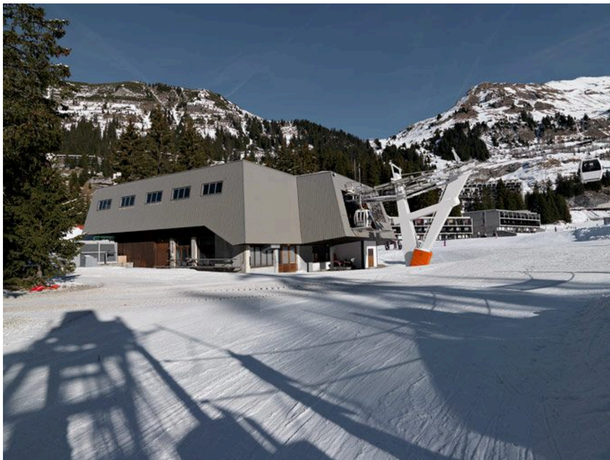
Vue depuis le sud-est
