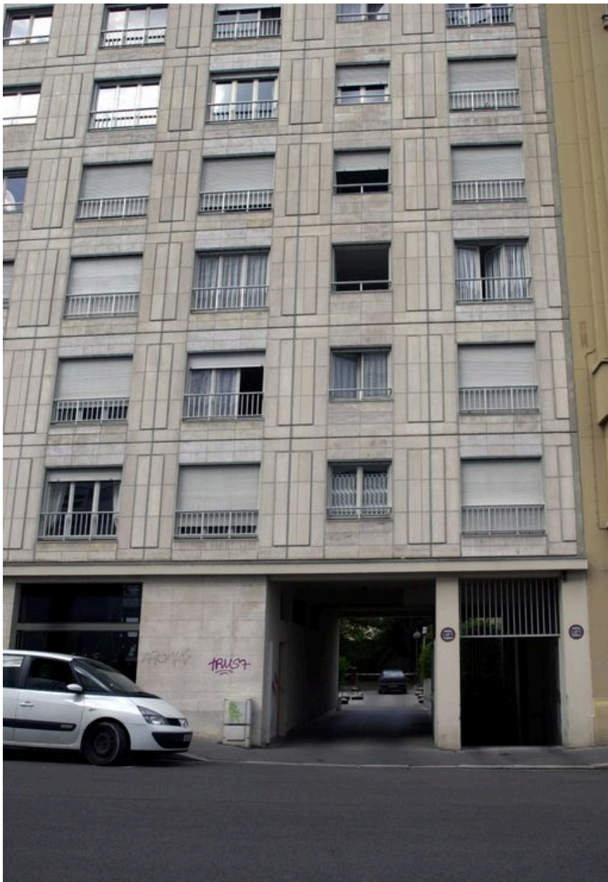
Elévation antérieure, vue partielle
