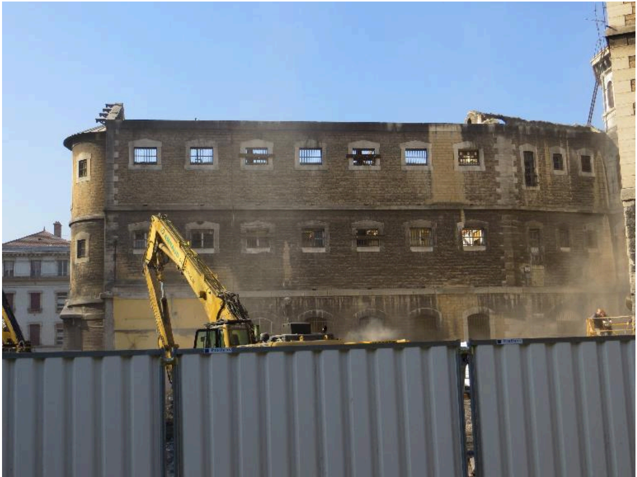
Etat au 19 février 2013 : élévation est de l'aile sud
