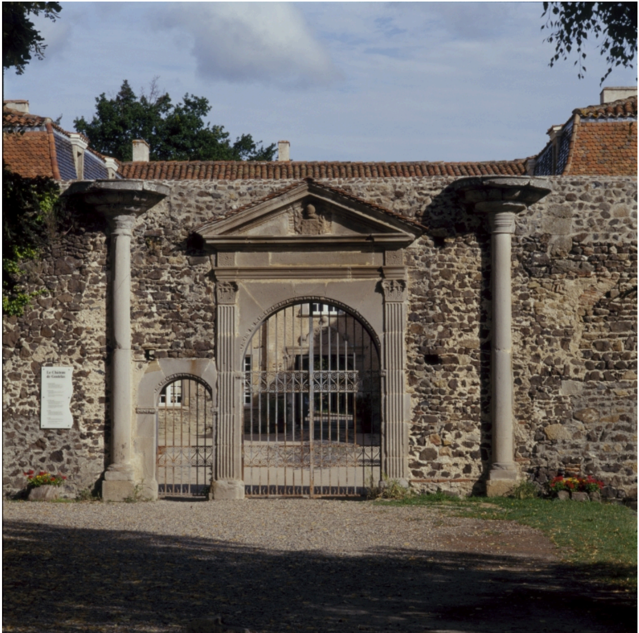
Détail du portail de l'entrée principale situé dans le mur d'enceinte sud-est, du sud-est.
