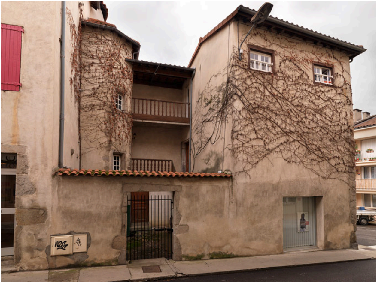
Vue depuis la rue du Palais-de-Justice : escalier en vis et galeries reliant les corps A et B.
