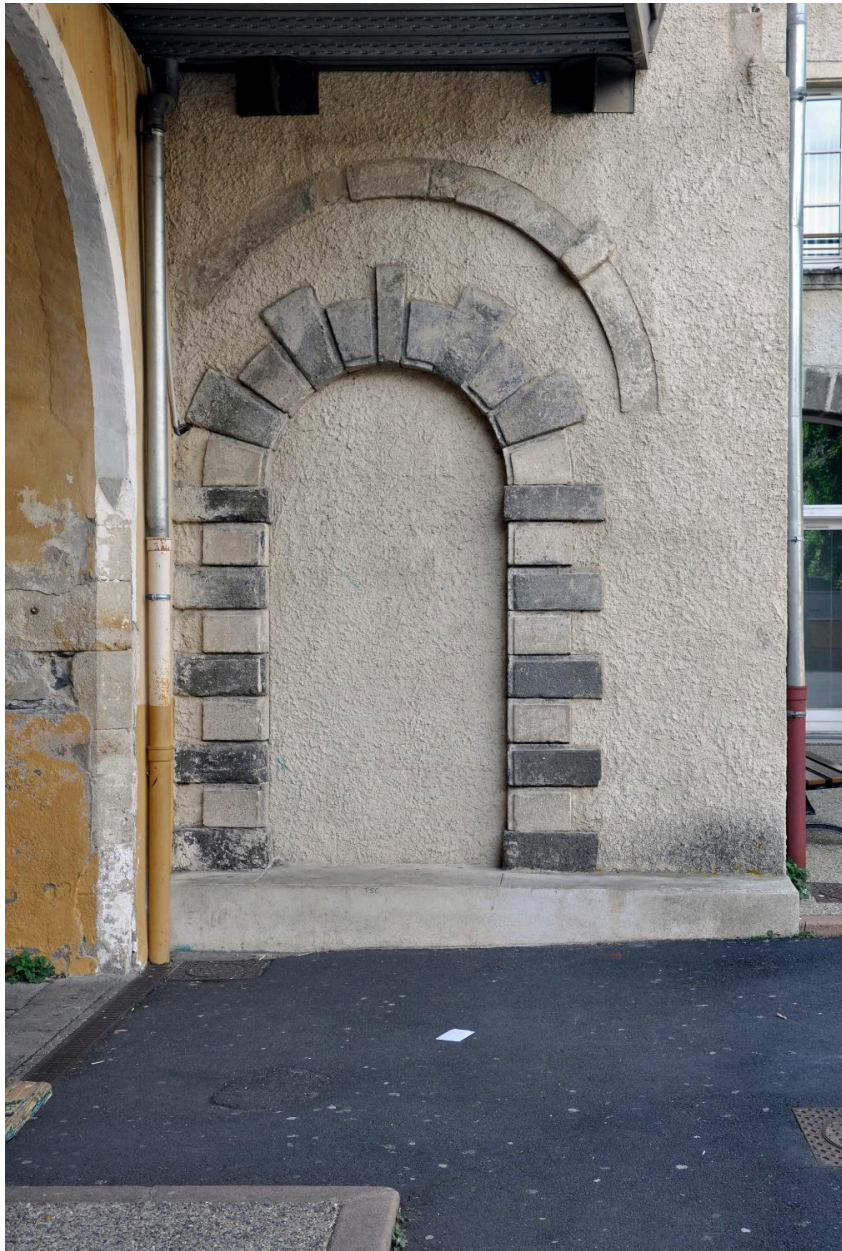
Elévation sud du pavillon ouest de la cour des pères : baie murée avant 1862.
