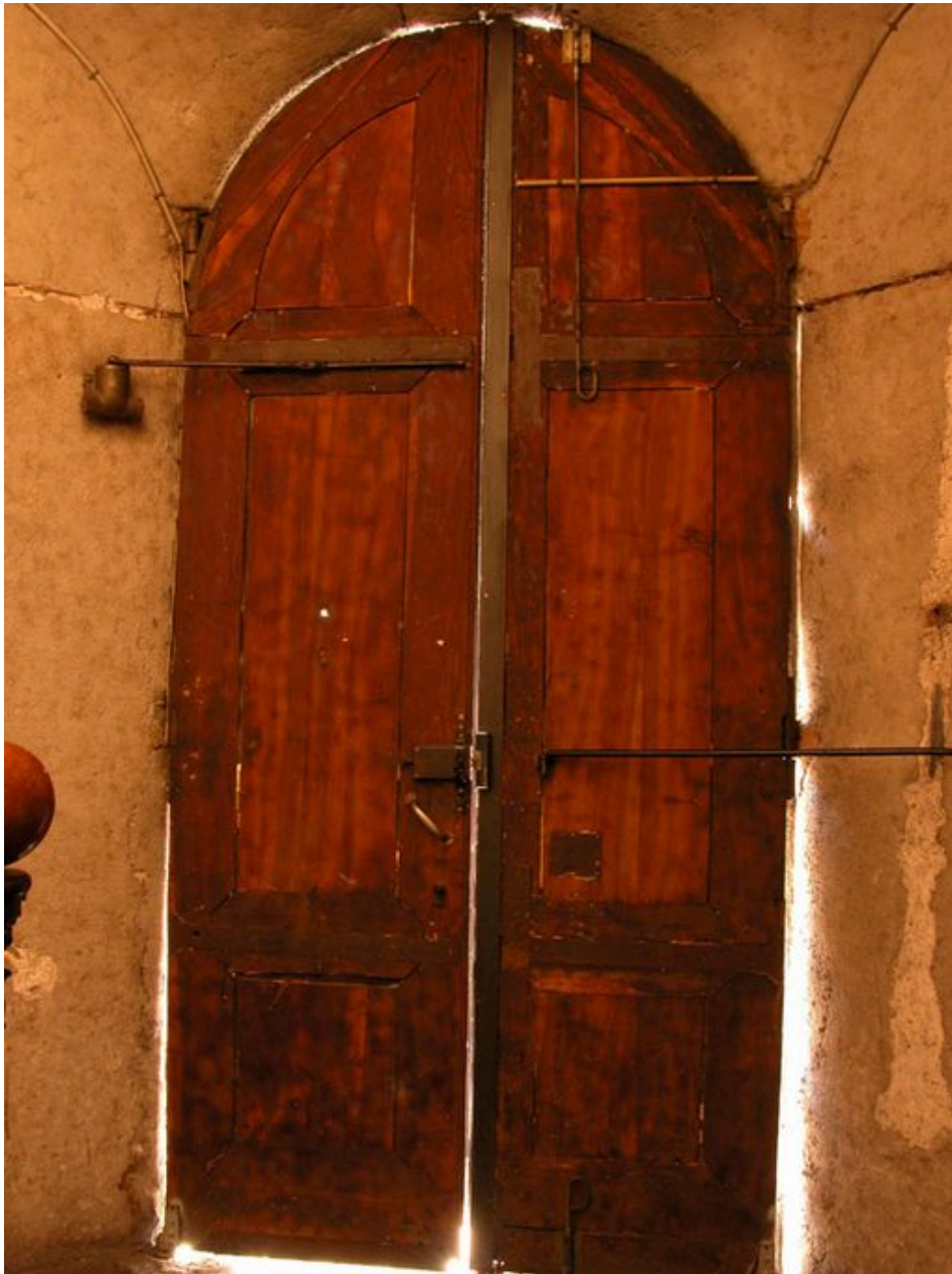
Détail de la porte : vue intérieure
