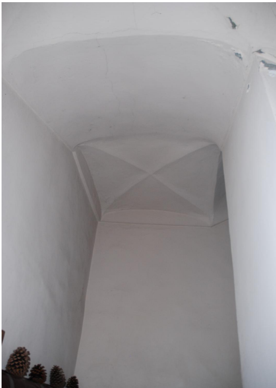
Maison, immeuble, 78 rue Louis Blanc-Pinget (2018 E1 341). Palier de l'escalier.
