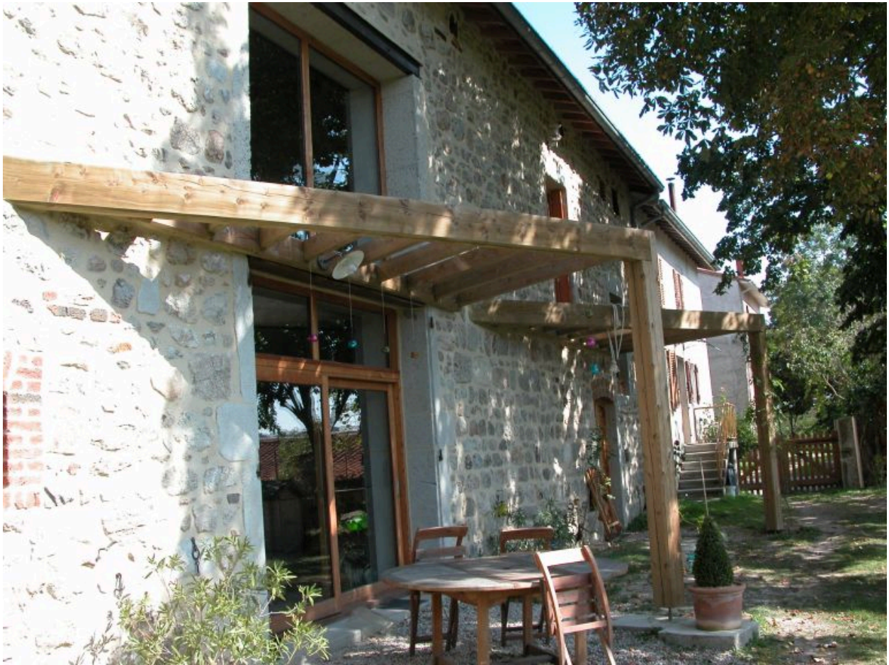
Vue d'ensemble de l'ancienne grange-étable modifiée en logement.
