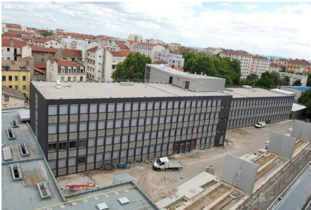
Vue du collège depuis le toit du garage Citroën, durant les travaux en 2010.
