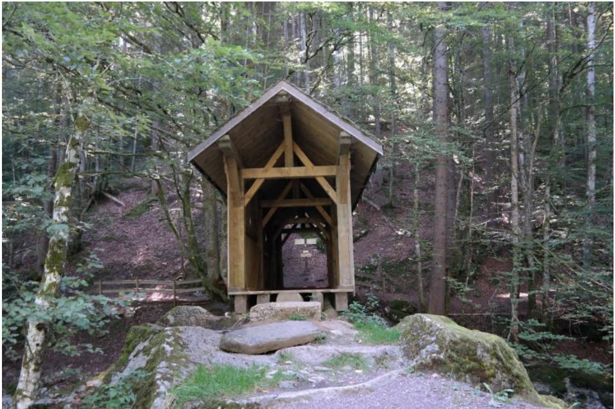
Pont couvert de Bellevaux, vue depuis la rive gauche
