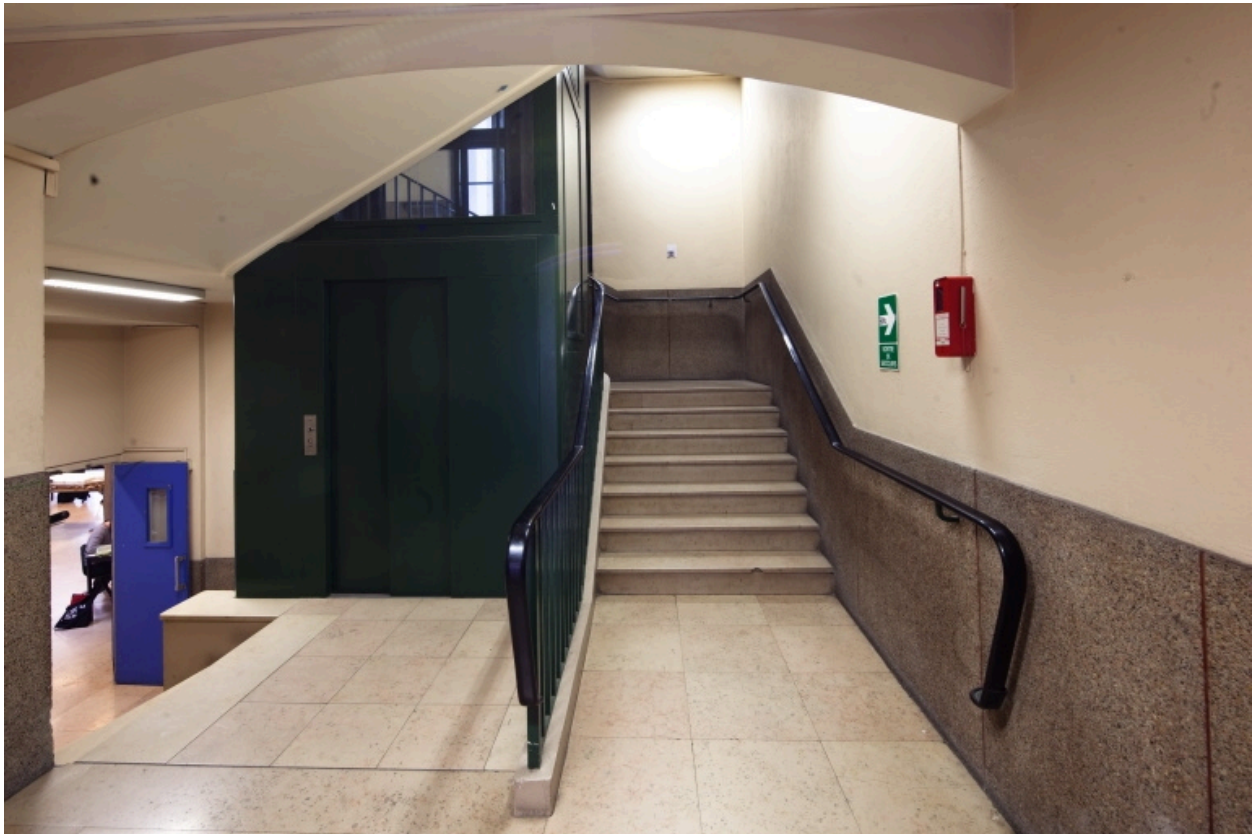
L'extension de 1950. Départ de l'escalier sur entresol et ascenseur.
