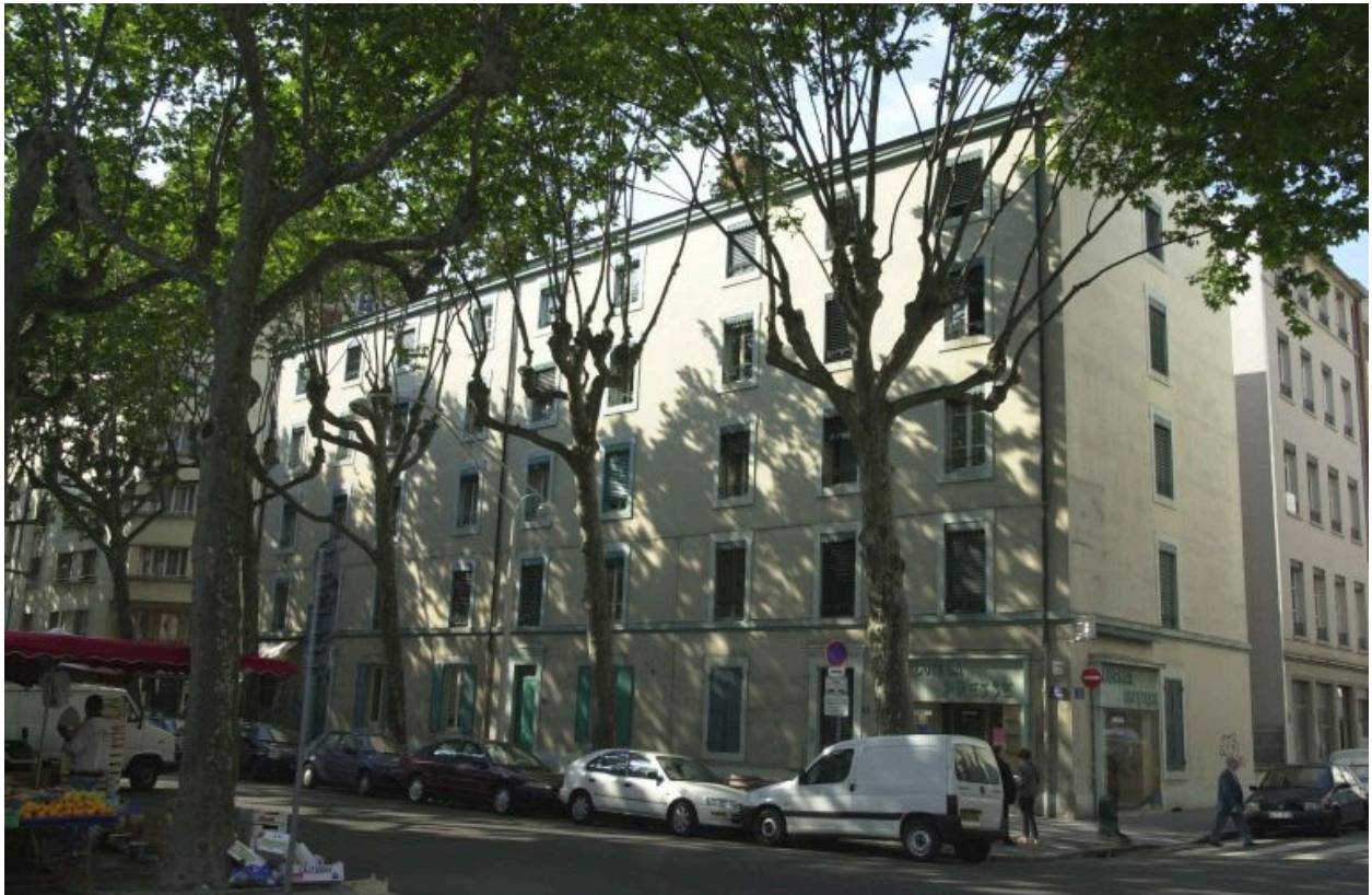
Vue d'ensemble des immeubles 18-22 cours Bayard, à l'angle de la rue Smith
