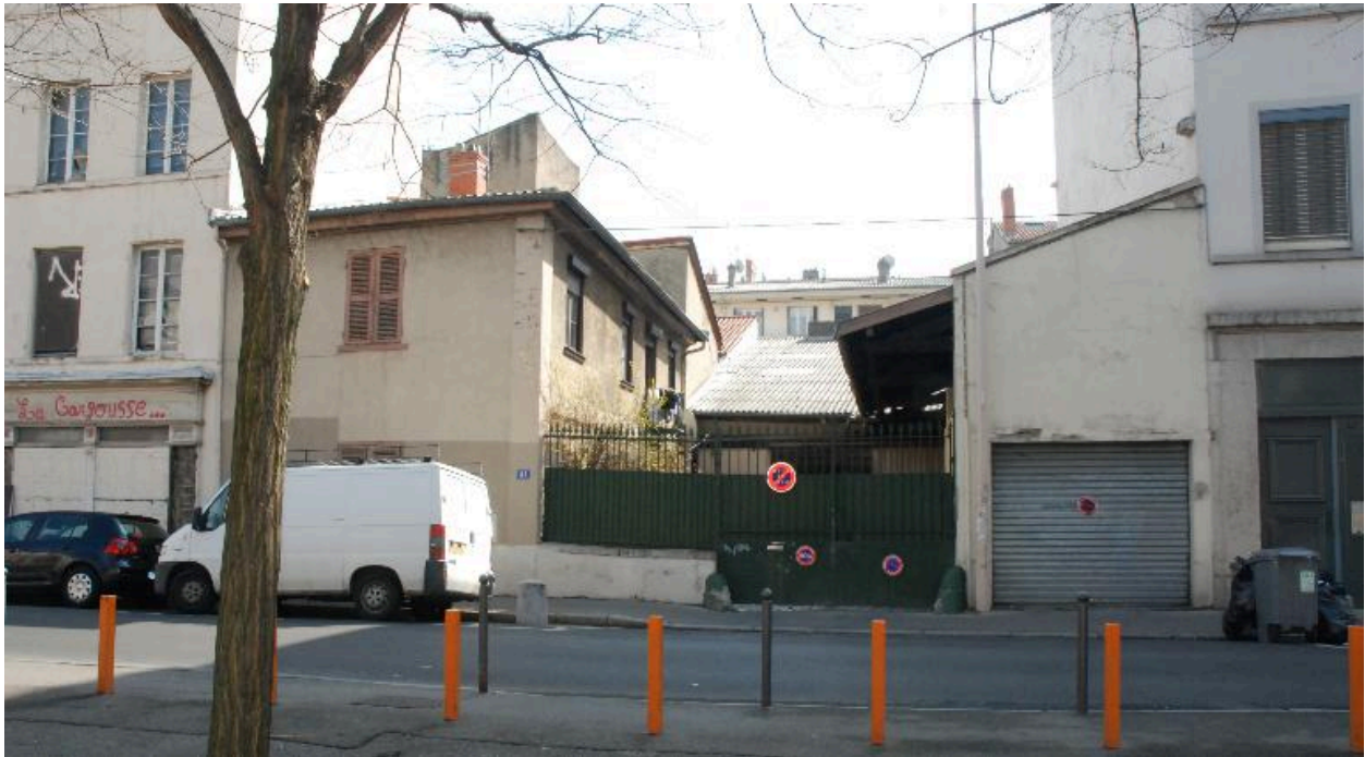
Maison démolie au 41 rue Sébastien-Gryphe (vue prise en 2012)
