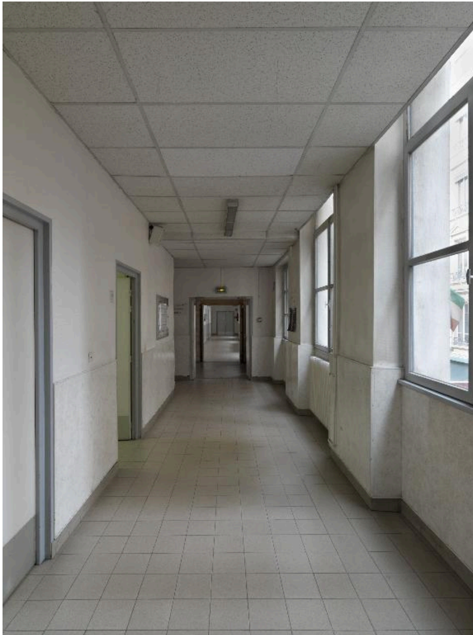
Cour d'honneur, corps de bâtiment nord, couloir du 1er étage, depuis l'est
