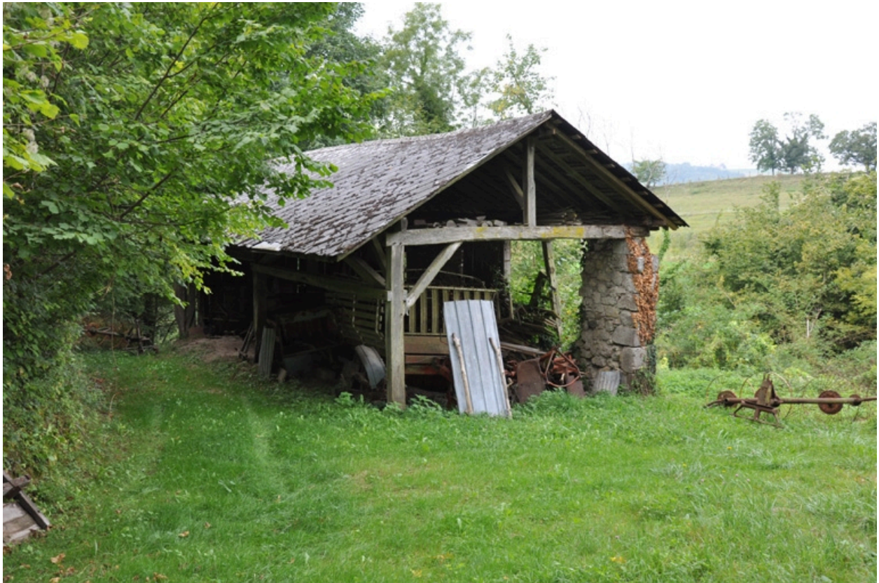
Vue générale, façade est
