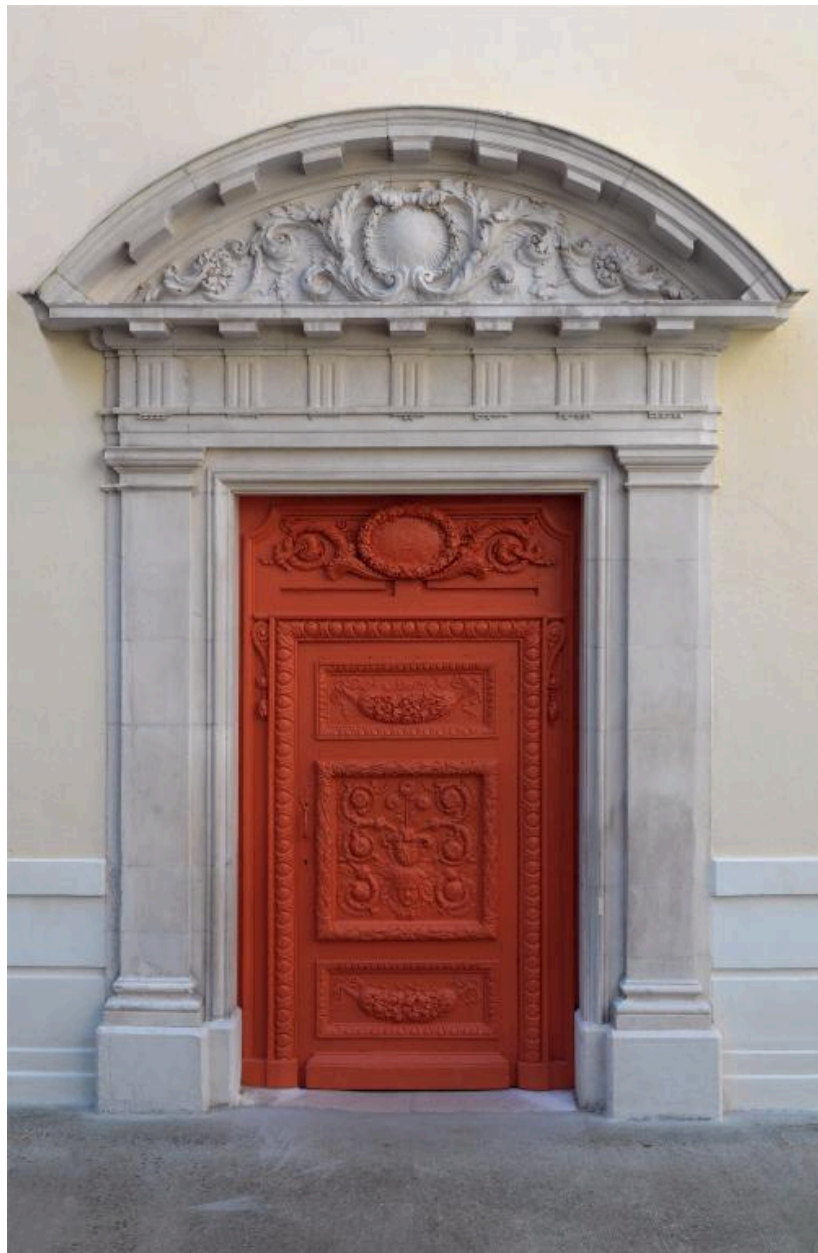
Corps de bâtiment sud : porte côté cour intérieure
