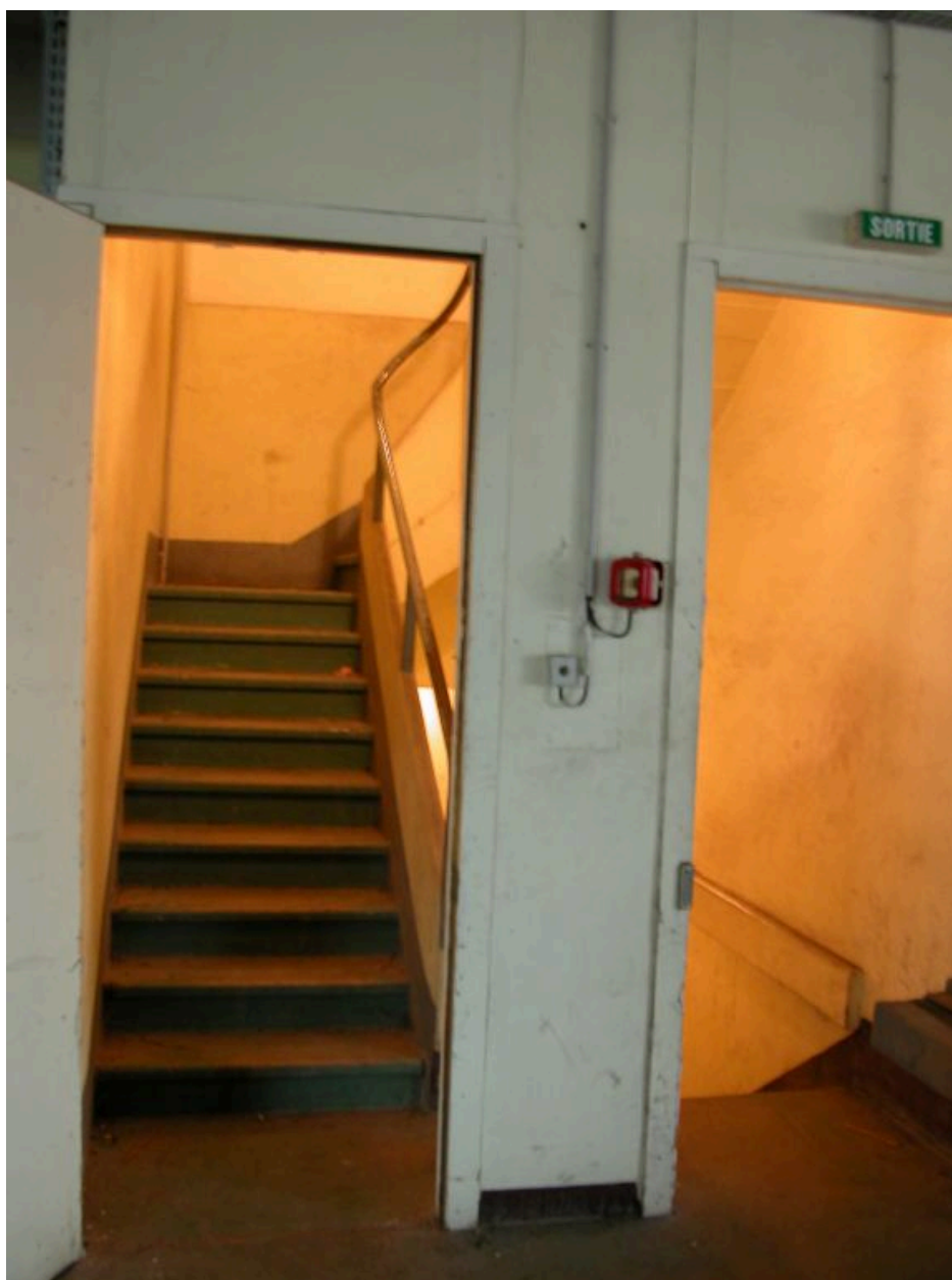
Détail d'un escalier permettant la communication entre les étages.
