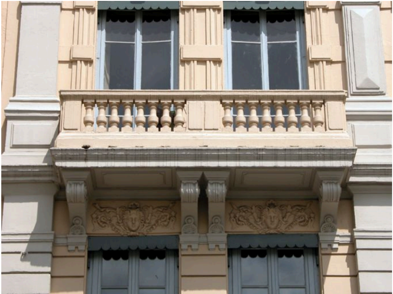
Façade sur le quai, 3e niveau, balcon de gauche
