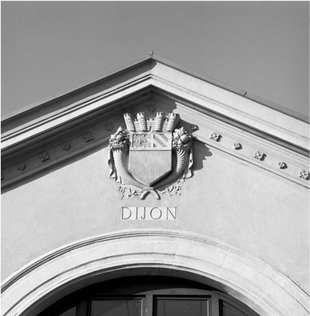
Le bâtiment-voyageurs : bâtiment latéral ouest, écusson aux armes de Dijon
