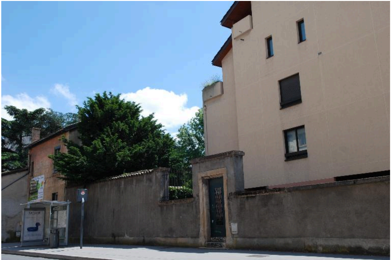
Vue du mur de clôture du n°15, faisant jadis peut-être partie du même ensemble.
