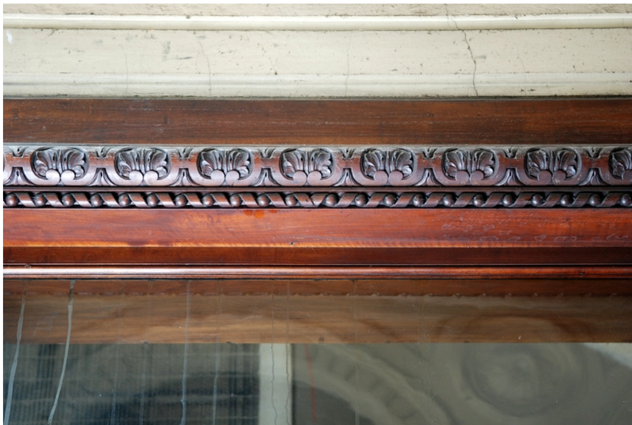
Corps de bâtiment ouest : moulure ornant la porte qui ouvre sur le porche
