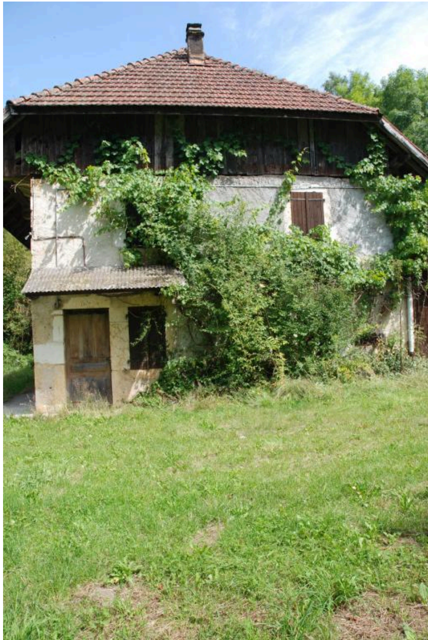
Vue d'ensemble de la façade de la parcelle 483, sur le mur pignon sud du corps de bâtiment.
