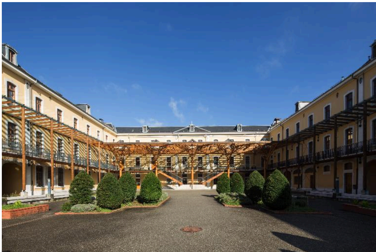
Cour 2 : galerie, vue générale.
