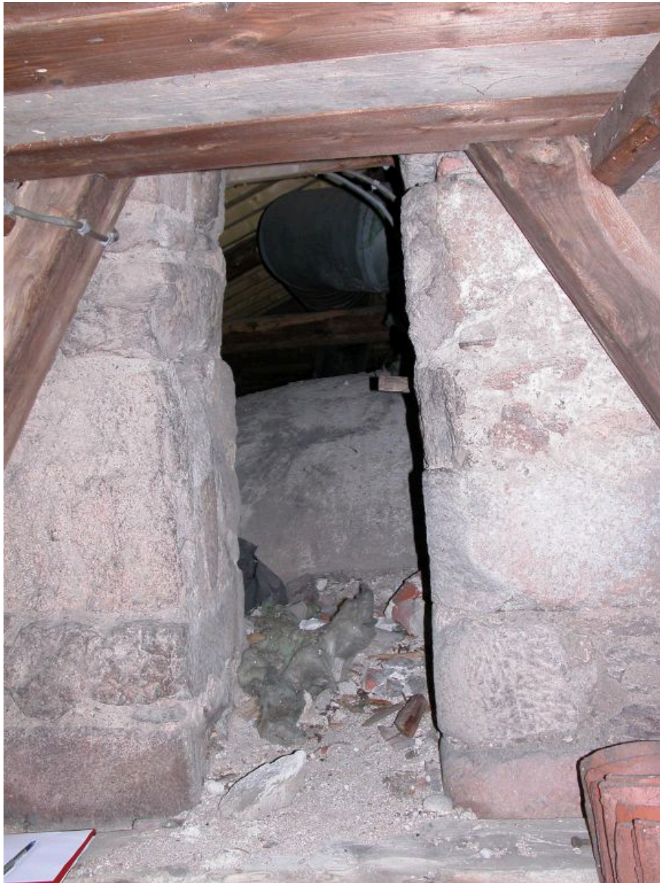
Passage d'accès au-dessus des voûtes de la nef depuis le mur ouest du clocher.
