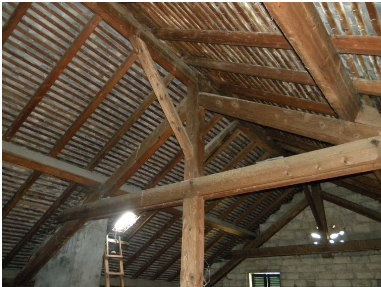
Vue de la charpente depuis le grenier.
