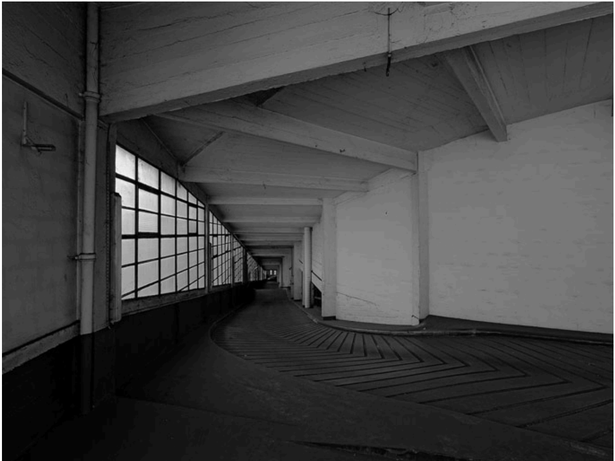
Rampe montante entre 4e et 3e étage
