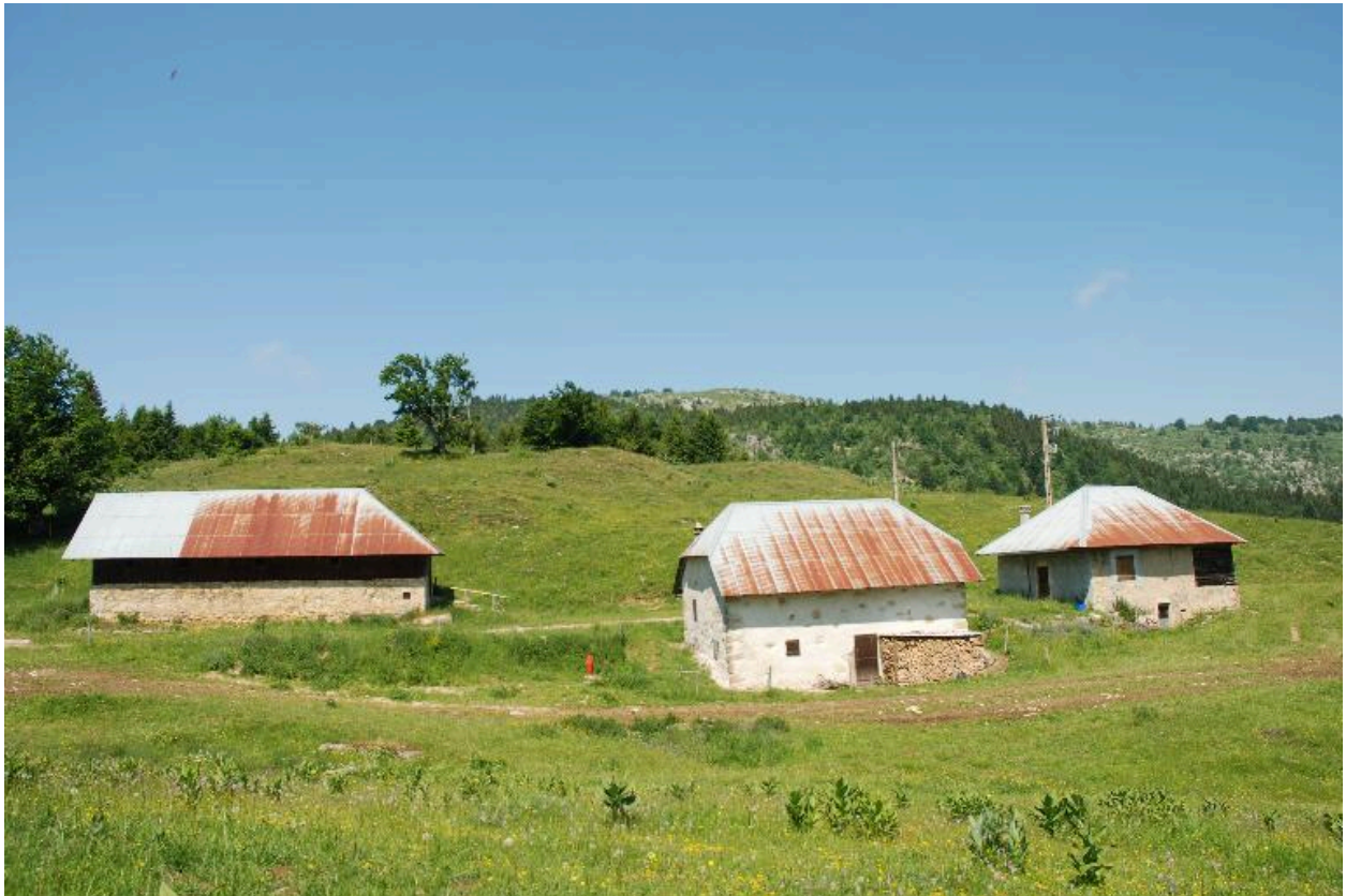
Vue générale depuis l'est.
